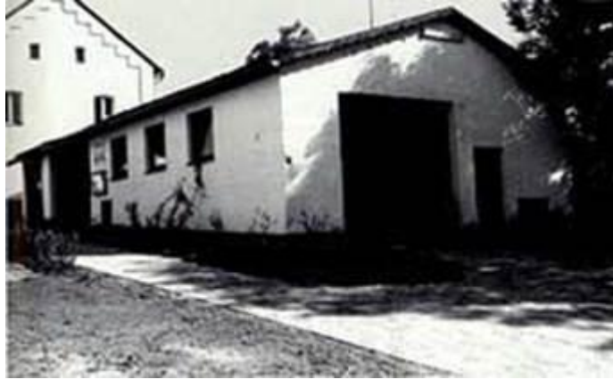
Feuerwehrhaus errichtet im Jahre 1969 und genutzt bis 1989
