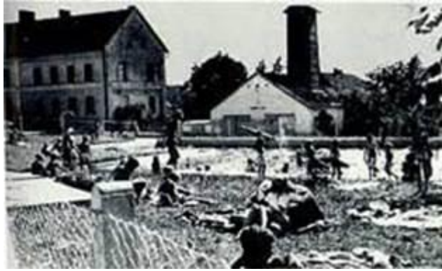
Das etwa um 1925 erbaute und mehrmals umgebaute Feuerwehrhaus, mit dem im Jahre 1951 errichteten Schlauchturm. Im Vordergrund der 1966 ausgebaut Löschweiher, der im Sommer auch als Freibad genutzt wurde.
